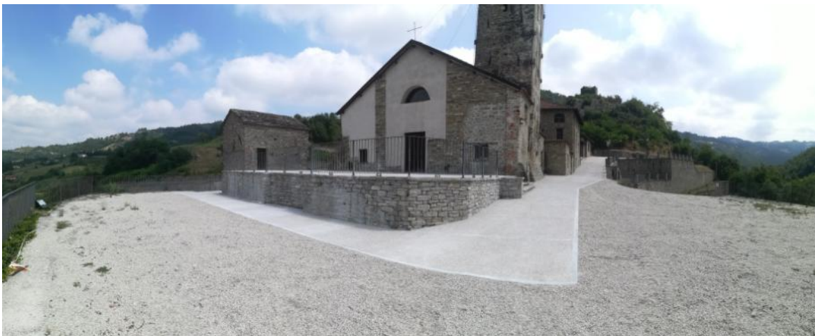
L'area perimetrale in ghiaia da pavimentare in Cls architettonico
