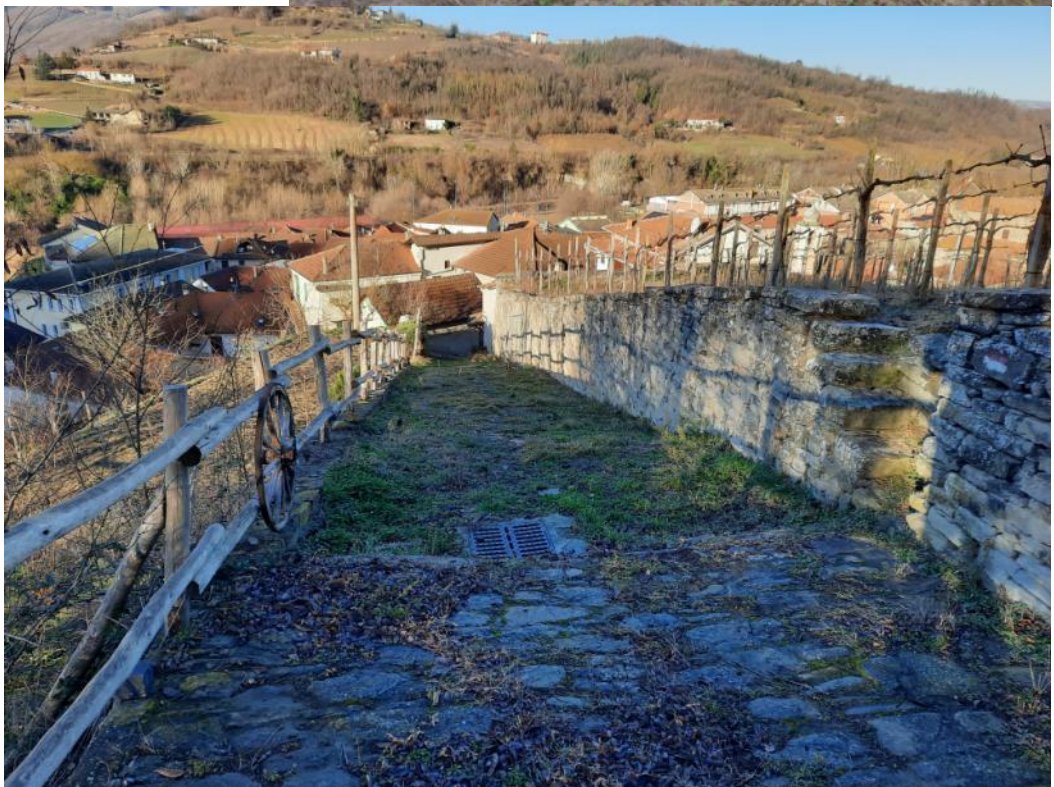
Il tratto di sentiero da pavimentare con materiali identici ai tratti di sentiero adiacenti (pavimentati in pietra di langa posata a giunti irregolari)
